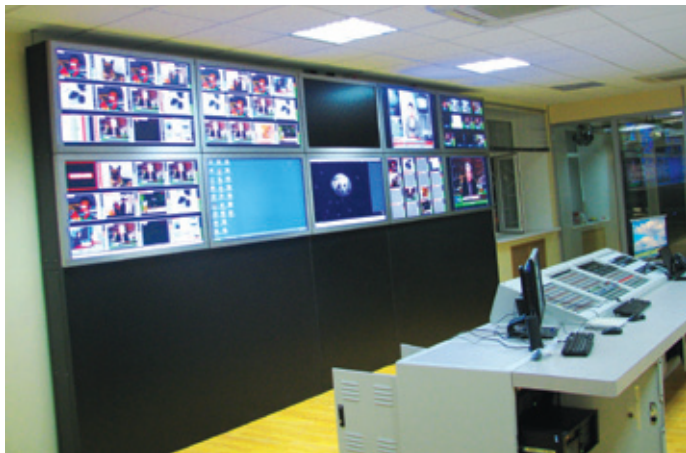
Система Stream Multiscreen TS в вещательной аппаратной
